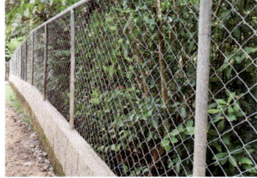
Foto 14: REPARACIÓN DE MURO PERIMETRAL DE BLOCK Y CAMBIO DE MALLA GALVANIZADA
