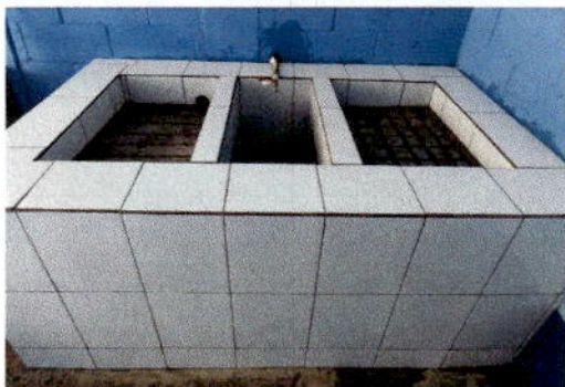
Foto 11: SUSTITUCIÓN DE PILA DE CEMENTO POR PILA DE CONCRETO REVESTIDA DE AZULEJO
