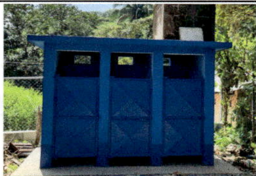
Foto 5: MANTENIMIENTO A PUERTAS Y PAREDES DE MODULO DE BAÑO (PINTURA, MARCOS, PASADORES)
