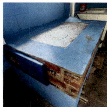
Foto 12: SUSTITUCIÓN DE ESTUFA INCLUYE CHIMENEA Y PLANCHA DE METAL
