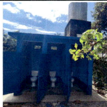
Foto 10: SUSTITUCIÓN DE LAS TASAS SANITARIAS DEL MODULO DE BAÑOS, CAMBIO DEL DEPOSITO DE AGUA, Y SUSTITUCIÓN DE TUBERÍA DE LINEA PRINCIPAL
