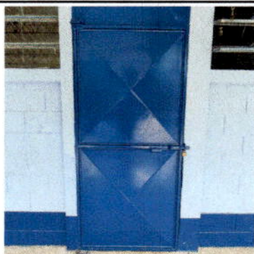
Foto 3: MANTENIMIENTO A PUERTAS DE AULAS (PINTURA, CAMBIO DE MARCOS)
