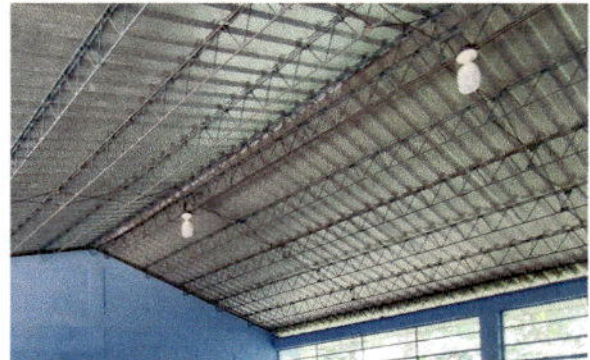
Foto 16: INSTALACION DE UNIDADES DE LUZ
