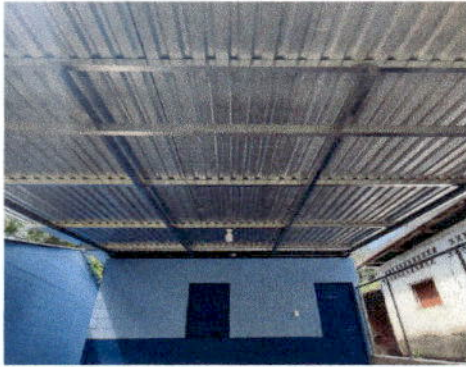
Foto 13: SUSTITUCIÓN DE SOPORTE DE MADERA POR METAL
