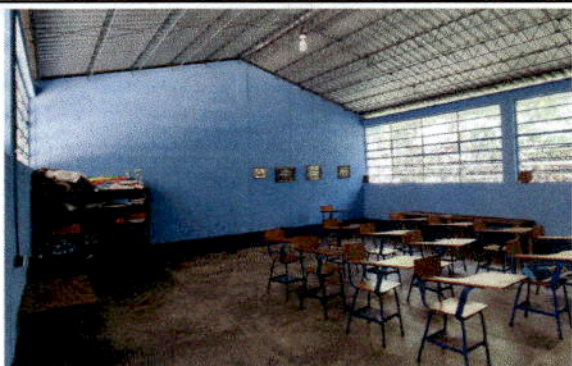
Foto 9: PINTURA DE MUROS INTERIORES DE TODA LA ESCUELA
