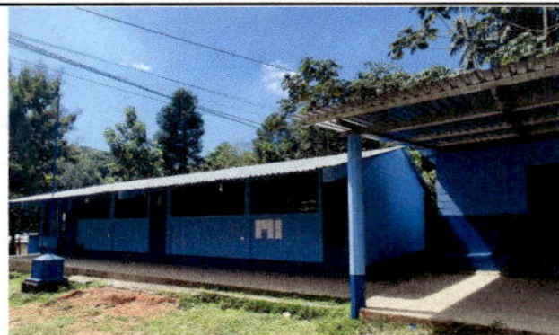
Foto 8: PINTURA EN MUROS EXTERIORES DE TODA LA ESCUELA
