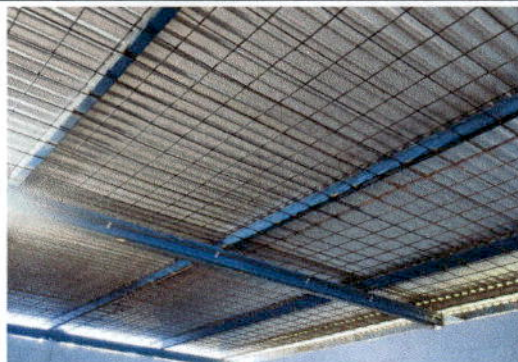
Foto1: CAMBIO DE LAMINA EN MODULO DE AULA
