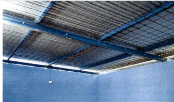
Foto 2: CAMBIO DE LAMINA EN MODULO DE AULA
